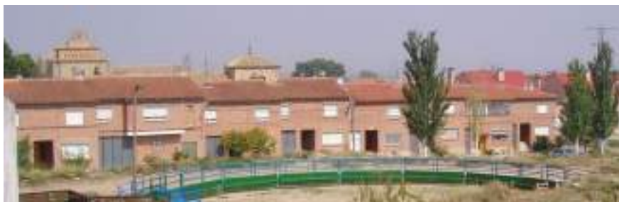
Fachada S / Calle de Chicul
