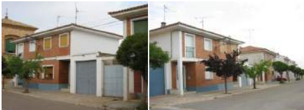
Fachada S / Calle de San Ramón
