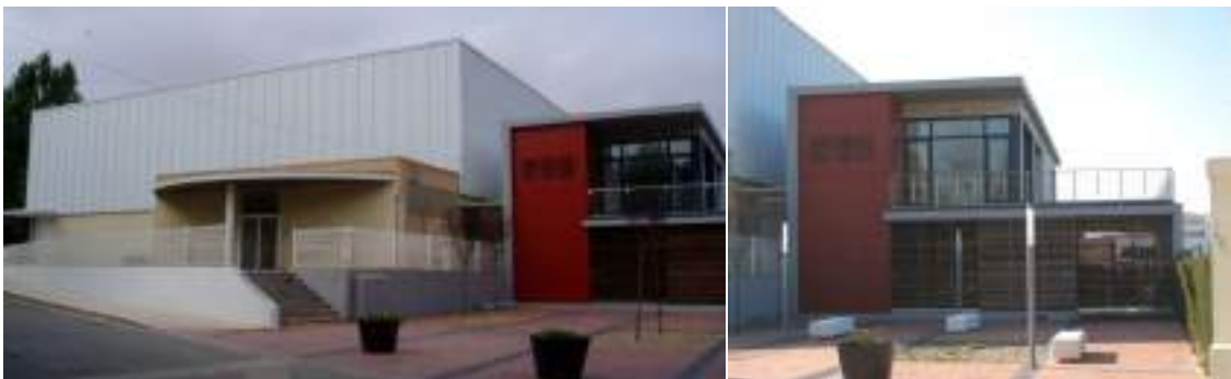
Pabellón Polideportivo y Gimnasio anexo, junto a las piscinas (Av. Zaragoza)
