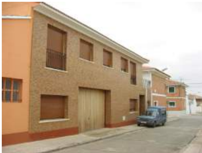
Casa nueva C/. Ferial (fachada E)
