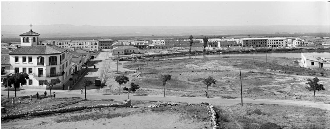
Vista de las obras desde el S
