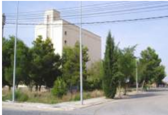
Zona verde en C/. Mayor, junto al Silo
