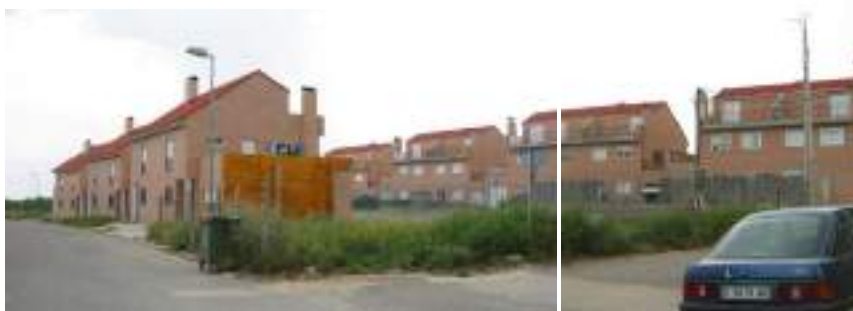
Fachada N (a calle Becú y a patio de manzana)
